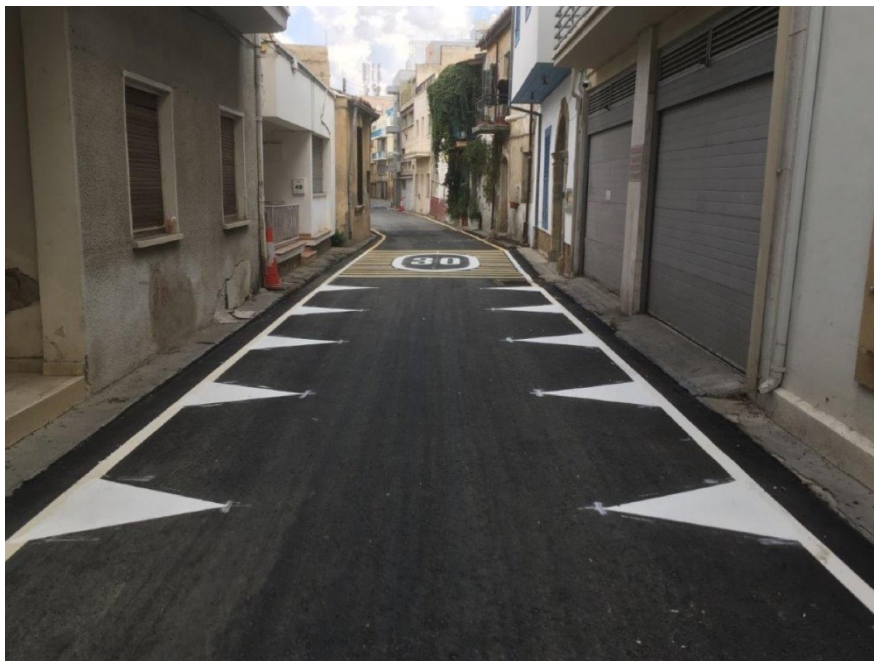
Εικόνα 22: Διαμόρφωση οδού ήπιας κυκλοφορίας με συνύπαρξη πεζού και οχημάτων στο επίπεδο του οδοστρώματος
