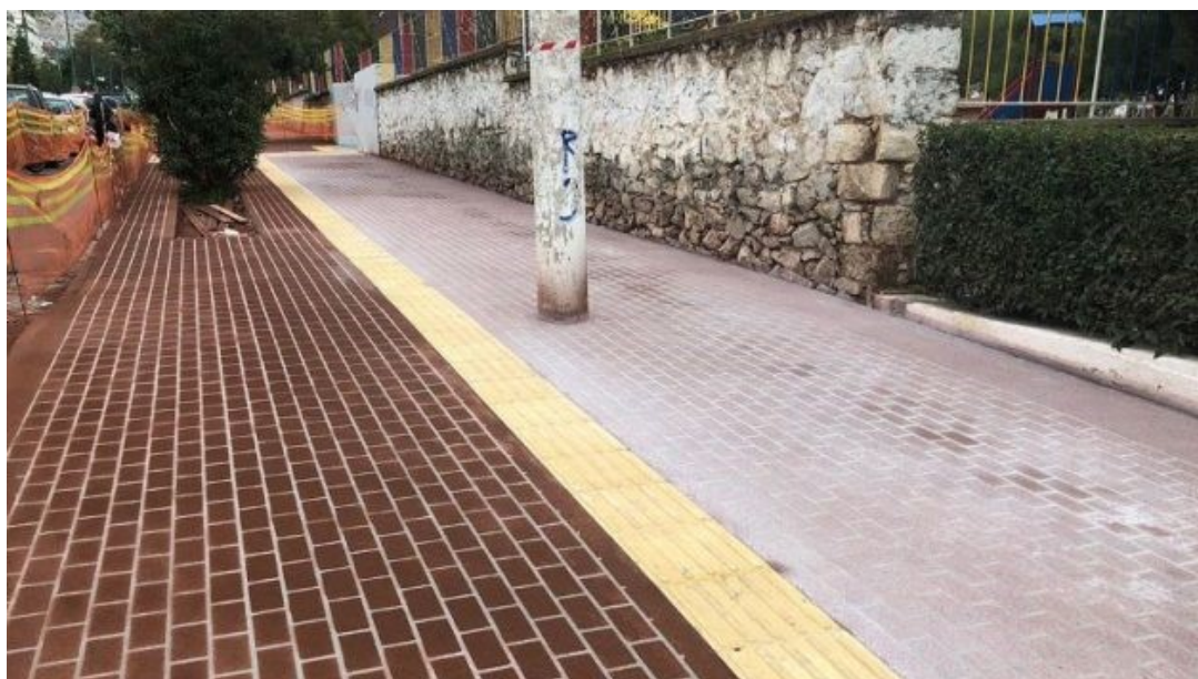
Εικόνα 2: Σταθερό, συνεχές και επιμελές αρμολόγημα (πηγή: https://www.michanikos-online.gr/ )
